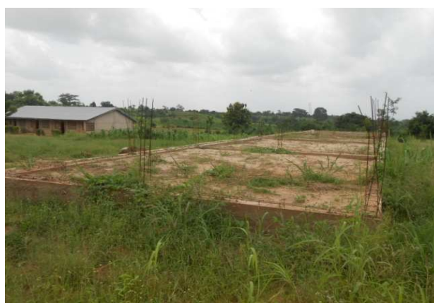
Chantier de trois classes à l'EPL la Grâce d'Abosséhoé
